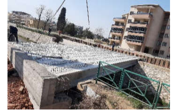
ÖNGERME KÖPRÜ (KESTEL)
